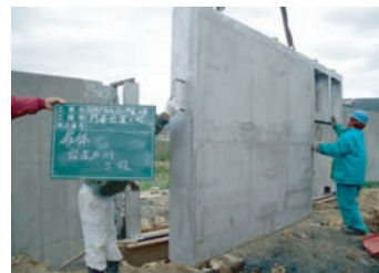
八重山支庁 比水川地区植栽及び門扉工事 防波堤扉
